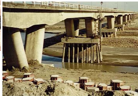
Sottoescavazione ponti (Fiume Reno, Germania)
